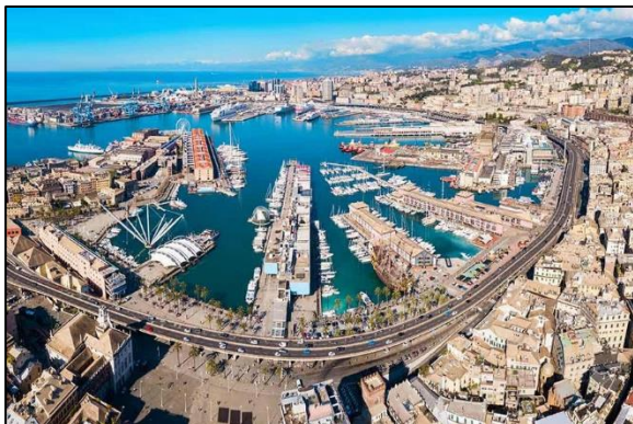
Il tracciato della sopraelevata sembra voler fare da cornice al porto.
