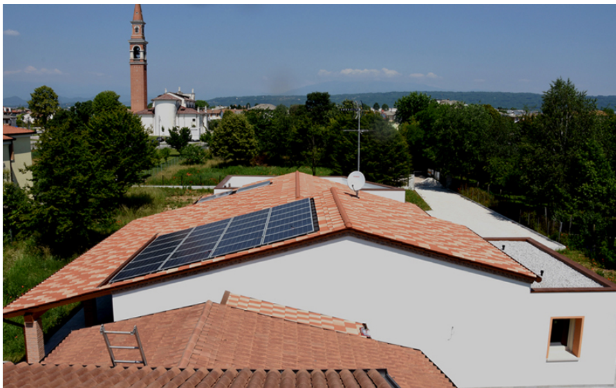
I pannelli fotovoltaici di casa mia
